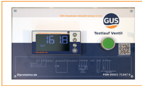
Schaltkasten (Steuermodul) IP65-geschützt und UV-beständig
